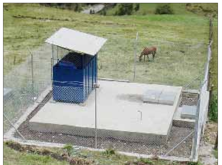
Geschützter Trinkwasser-Verteiltank.
